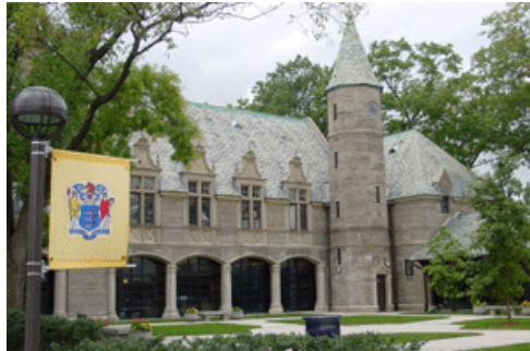
Edificio de administración
